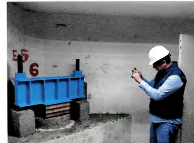
Supervisión de los Trabajos de Mantenimiento en el sistema de Pilotes de Control en la ESIME Azcapotzalco
