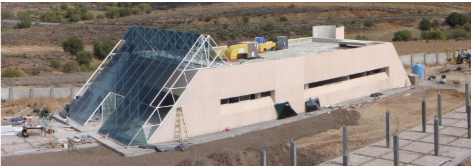
Construcción de Edificio de cafetería, servicios:
